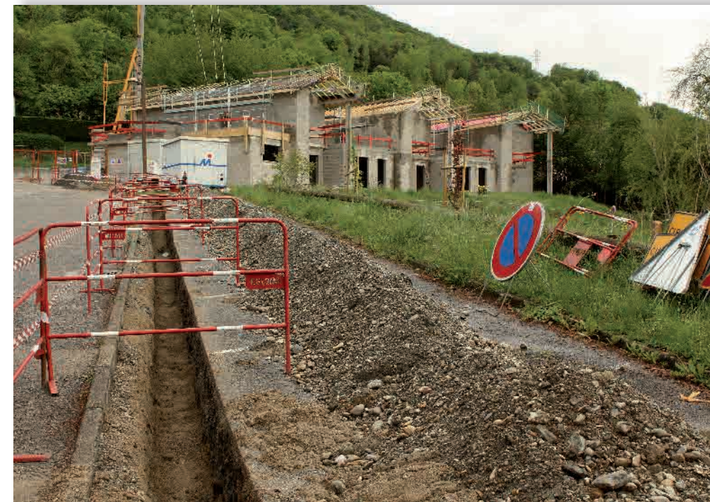
Construction montée des Claires, fin avril.
