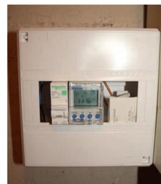
Armoire électrique avec horloge astronomique pilotant l'éclairage public
